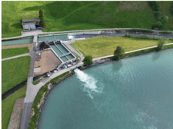
Neues Fassungswehr Eugenisee, Foto belop gmbh
