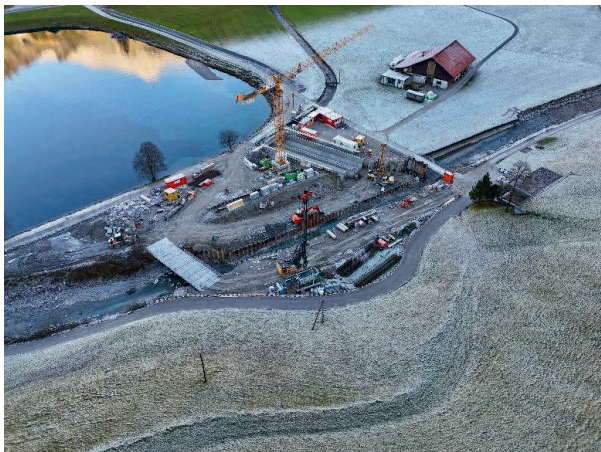
Spundwände trennen die Engelberger Aa, Foto belop gmbh
