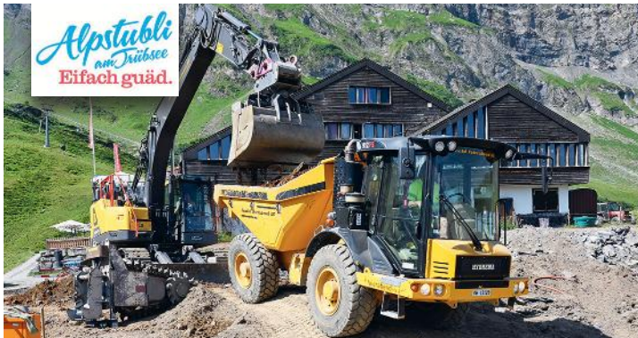
Die Aushubarbeiten für das Fundament des neuen Alpstubli am Trübsee sind weit fortgeschritten.
